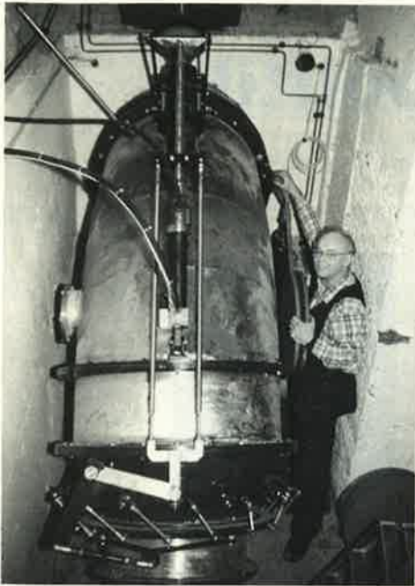
Vollständig renoviertes Wasserkraftwerk Lochmühle, Huttwil BE, der Strickwarenfabrik Frilo, Huttwil.
